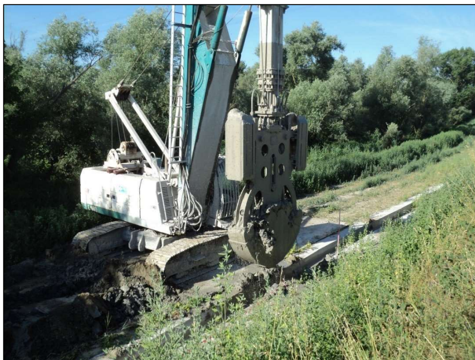
Figura 3 - Fase di scavo del diaframma - intervento di classifica RO-E-1432 – Cavanella Po (Adria, RO).
