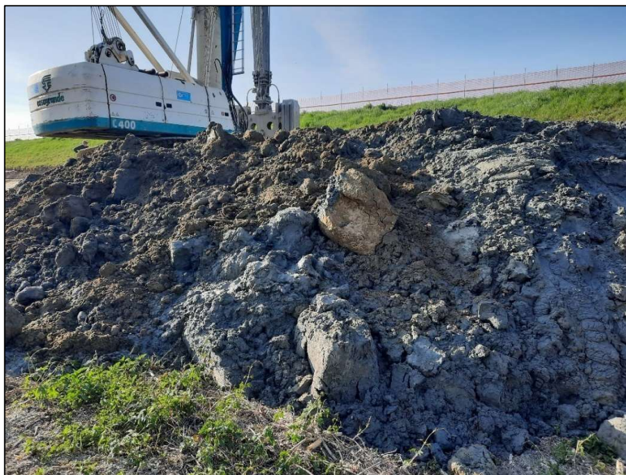
Figura 4 - Materiale escavato depositato ai margini dello scavo - intervento di classifica RO-E-1432 – Cavanella Po (Adria, RO).
