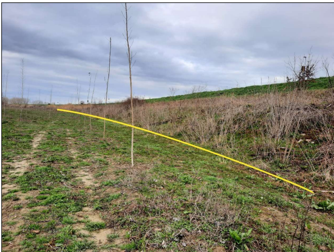
Figura 7 - Foto dell'area d'intervento con vista verso monte – unghia arginale a fiume con ubicazione dell'area di imposta del diaframma (linea gialla).
